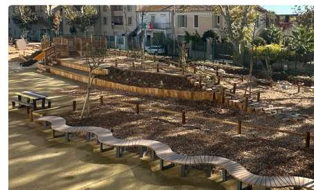
Désimpermeabilisation des cours d'écoles
