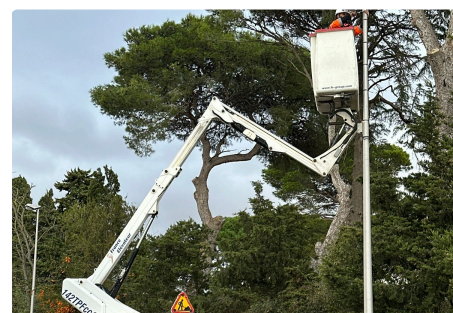
Rénovation de l'éclairage public
