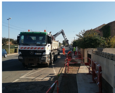
Enfouissement des réseaux secs du bd des dunes et du bd de la Tour du Guet
