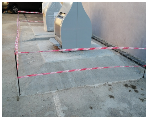
Mise en place de conteneurs enterrés collectifs au village et à Portiragnes plage
